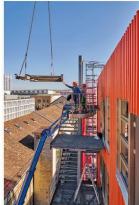
Detailgenauigkeit bedeutet hier, dass die aussenliegende Treppe, die von einem Bürohaus in Zürich stammt, mit einer Toleranz von 15 Zentimetern «genau» passt.
