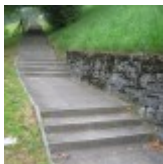
Treppen- und Rampenwege
