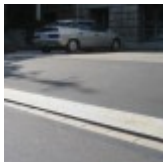
Abgesenkte Randsteine schräg mit Anschlag
